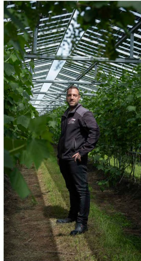
Afb 45. Fruit- en aspergekweker Maarten van Hoof in zijn agrivoltaics systeem. Bij Van Hoof Zachtfruit & Asperges versterken landbouw en technologie elkaar. De zonnepanelen die boven de frambozen en rode bessen zijn geïnstalleerd beschermen het fruit tegen extreme weersomstandigheden zoals regen, hagel en hitte, terwijl ze tegelijk duurzame energie opleveren. Foto: Roos Pierson.
